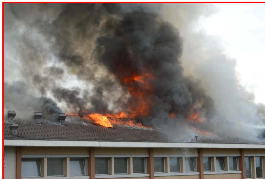
Feu de toiture collège des Crosets Vevey, septembre
